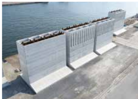
横浜港 [ 新本牧地区 ] 護岸（神奈川県）
