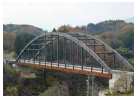
逢隈橋（福島県）
