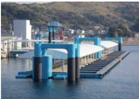
佐賀関漁港浮栈橋（大分県）
