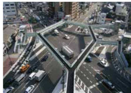
杭全横断歩道橋（大阪府）
